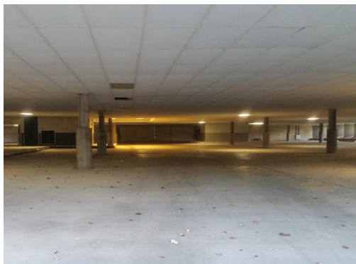
SUBLEVEL PARKING GARAGE
